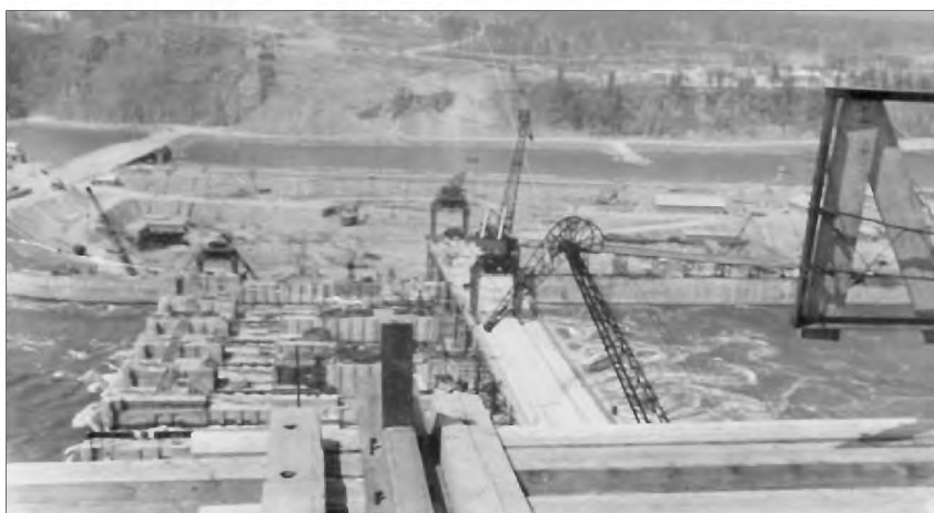
Барилга хэжэ эхилһэн плотина руугаа Ангар мурэнөө урадхуулаад, хойто талыень хаажса байна.
